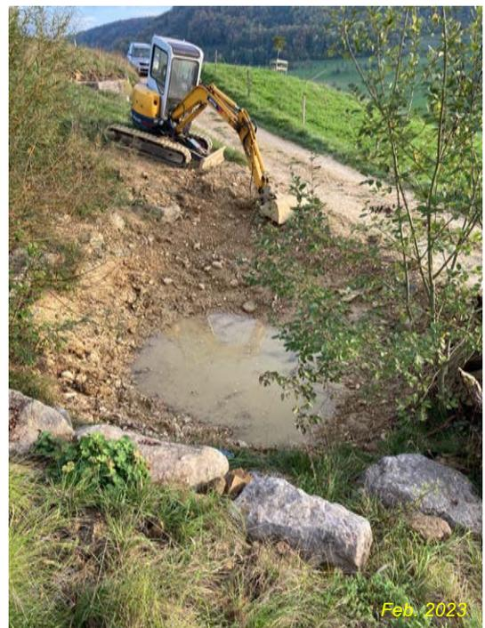
*oben:* Nach dem Ausbaggern des Geschiebes wurde die defekte Folie durch eine neue EPDM-Folie ersetzt. Ein ca. 8 cm dicker Schutzmörtel wurde aufgetragen und der Rand mit Mergelmaterial bedeckt.
