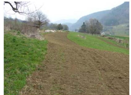
*Oberbodenabtrag am Standort der Trockensteinmauer inkl. etwa 4 m vor der Mauer. Diese Fläche diente auch als Baumaschinenzufahrt zum Weiher- und Mauerbau.*
