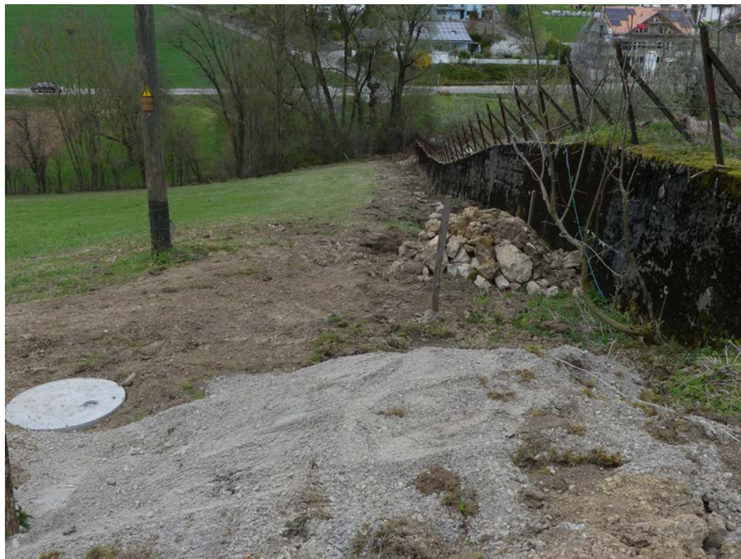
Links der Abzweigschacht der Brunnenleitung. Dort kann auch die Wassermenge des Bächleins reguliert werden. Unterhalb des Steinhaufens fließt das neue Bächlein. Der Sand- und Steinhaufen gehören zu den Kleinstrukturen, welche die Unterschlupf- und Substratvielfalt erhöhen. April 2017
