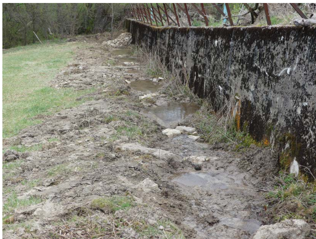
Nach der Fertigstellung der Bauarbeiten mit Schwelleneinbau. April 2017
