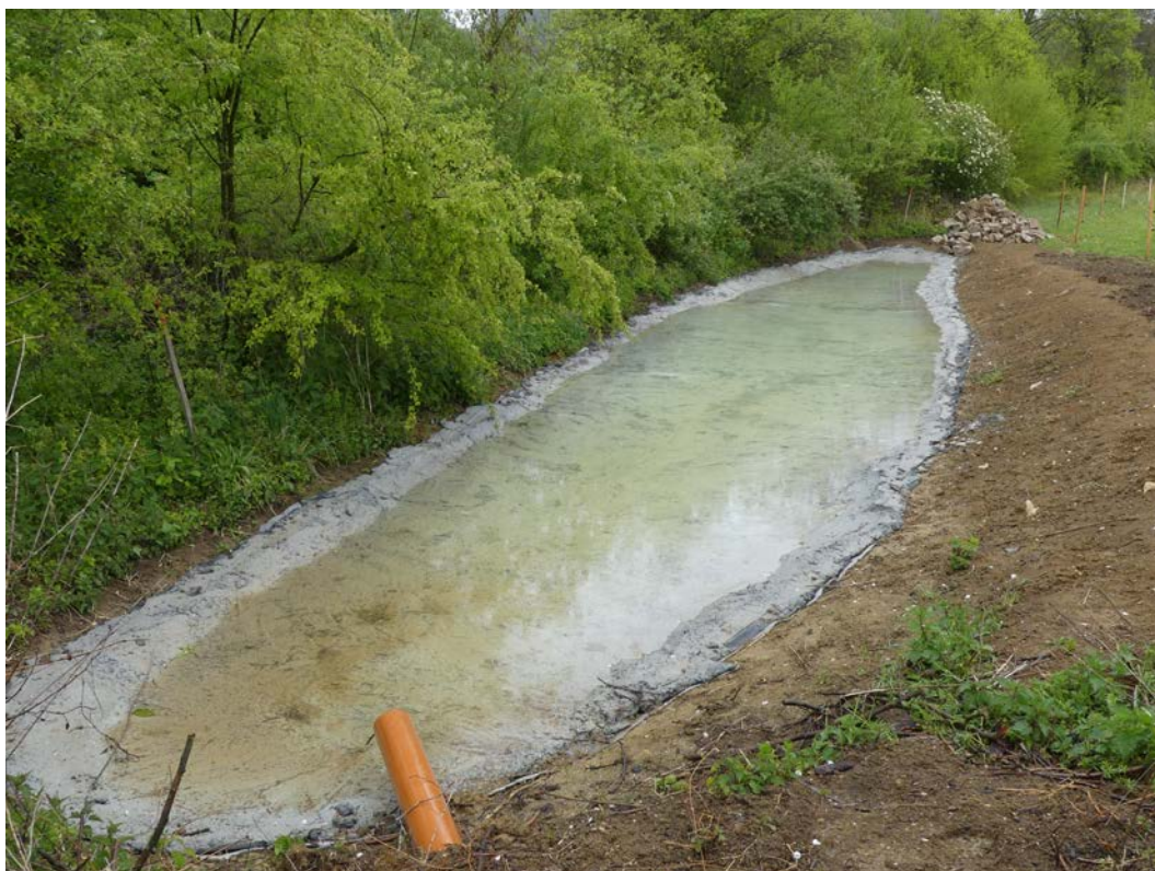
Wenige Tage nach der Fertigstellung wurde der Teich mit Wasser vom nahen Buechbächli gefüllt. Ein permanenter Zufluss ist nicht vorgesehen. Der neue Schutzmörtel (ca. 7-10cm dick), welcher die Kautschukfolie mechanisch schützt, wird in wenigen Monaten von Algen bewachsen sein. Im Sommer werden Staudenstücke von Sumpfpflanzen an den flachsten Stellen eingebracht, um den neuen Weiher mit Kleintieren und Pflanzen zu "impfen". April 2017
