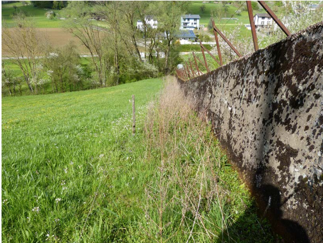
Die Lage des Bächleins vor dem Bau. Dem Mauerfuss entlang besteht bereits jetzt ein sumpfiger Streifen Grünland. April 2016
