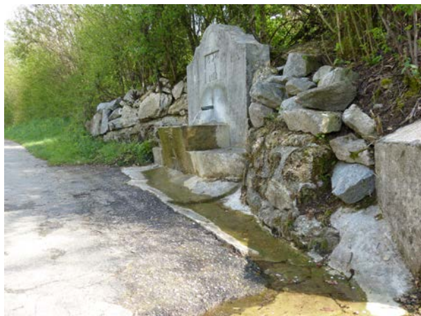
Der Brunnen an der «Alten Landstrasse». Der Überlauf speist das Bächlein. Dazu wurde nach der Unterquerung der Strasse ein Abzweigschacht in die Leitung eingebaut.
